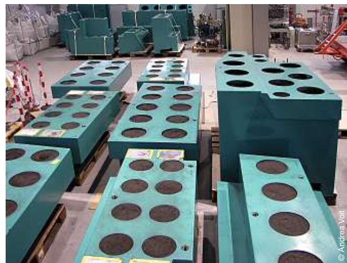
Die grünen Steine der neuen Radiografieanlage sind mit dem pulverigen Abschirmmaterial gefüllt.
