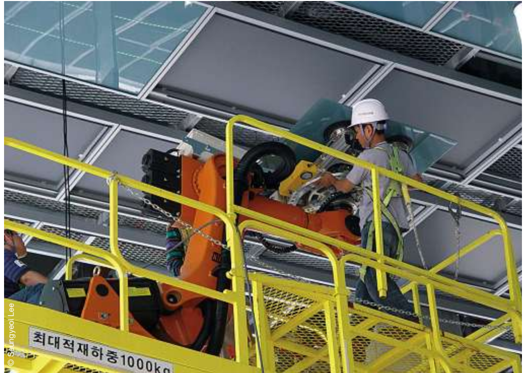
Premiere: Erste Mensch-Roboter-Kooperation auf einer Baustelle
