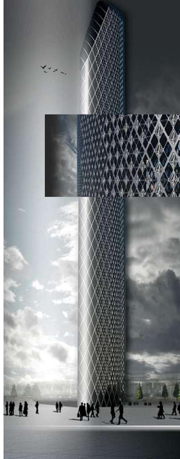
Dieser Entwurf setzt auf Windkraft zur Erzeugung von Energie: Die Gebäudehülle ist mit vielen kleinen Rotoren (s. Detail) bestückt, die frontal oder laminar angeströmt werden.
