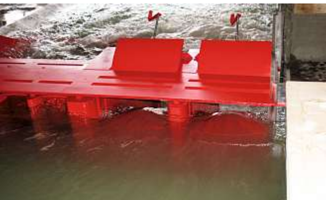
Überströmte Wehrfelder von oben
