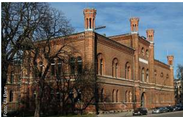
Das Gebäude des ZLL in der Lothstraße
