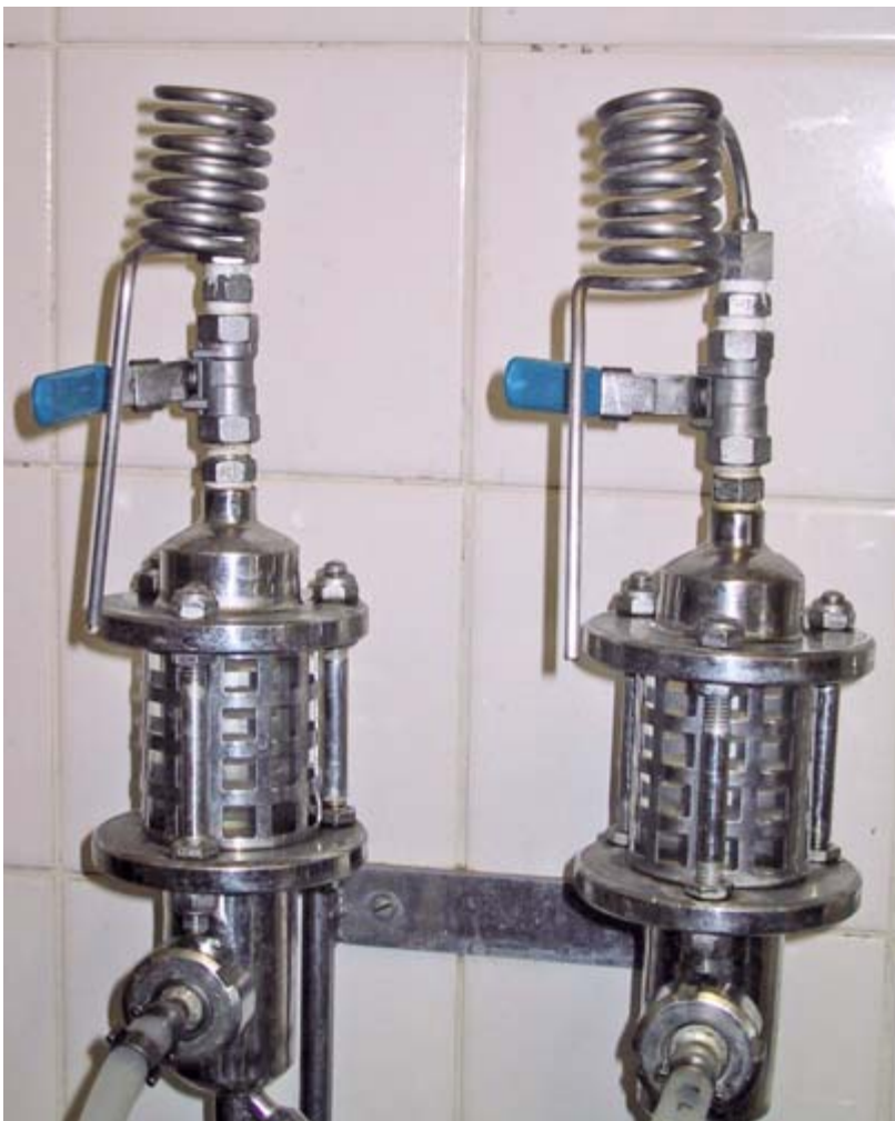
Schaugläser zur Kontrolle des Durchflusses am Filtereinlauf des Pilotfilters
