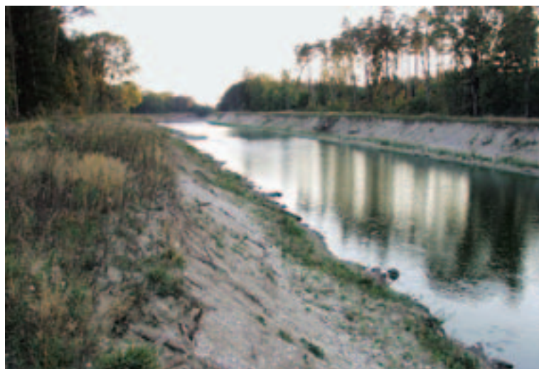
Ufer der Wertach nach dem Rückbau der Uferbefestigung. Der Fluss hat sich nach dem ersten Hochwasser im August 2002 bereits um mehr als fünf Meter aufgeweitet. Foto: Tobias Hafner
