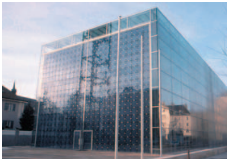
Die bauaufsichtliche Zustimmung für die in Stahl-Glas-Bauweise erbaute Herz-Jesu-Kirche in München wurde auf Grundlage von Gutachten der TUM erteilt.
