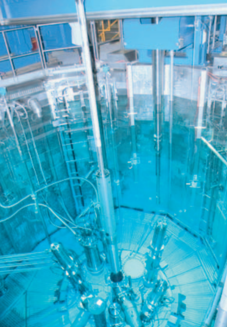
Ein Greifer transportiert das Brennelement (der untere, glänzende Teil an der Stange) unter Wasser vom Absetzbecken zum Reaktorbecken und setzt es in den Zentralkanal des Moderator-tanks.
