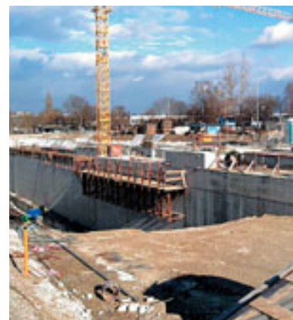
U-Bahn-Baustelle für die neue »University Line« in Garching
