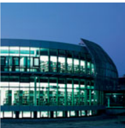
han Foto: Staatl. Hochbauamt Freising
