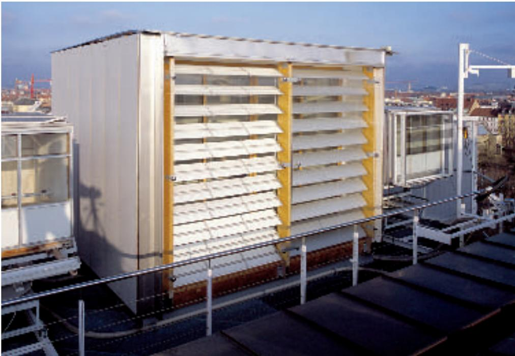
**Fassade der Solarstation auf dem Dach der TUM; links Glaslamellen, rechts Alulamellen.**
