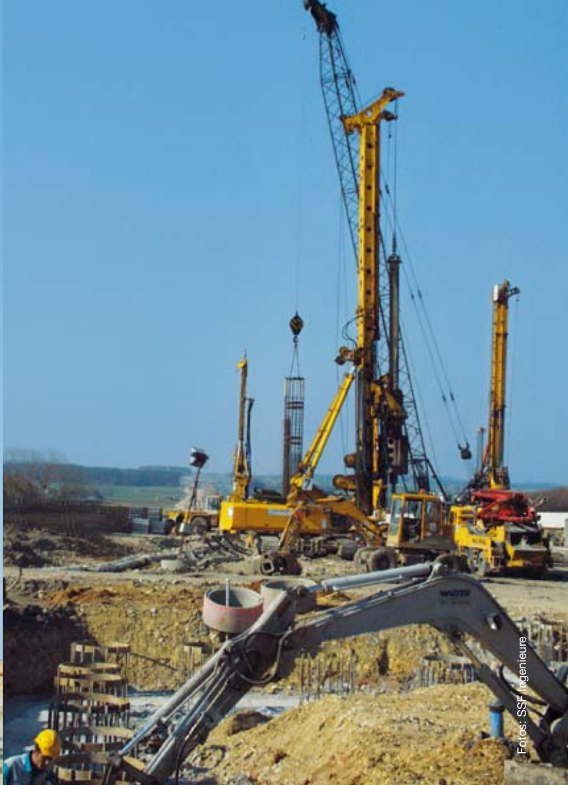
Gründungsarbeiten für eine neue ICE-Trasse: Bohrpfahlgründungen halten die „Feste Fahrbahn“, ein Stahlbetonträgersystem, in das Geleise verschraubt werden. Nach der Bohrung werden die zylindrischen Bewehrungskörbe eingesetzt, die mit Beton vergossen werden
