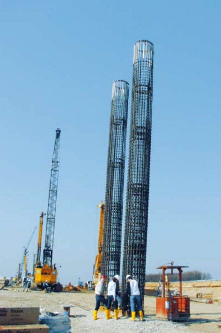
Gründungsarbeiten für eine neue ICE-Trasse: Bohrpfahlgründungen halten die „Feste Fahrbahn“, ein Stahlbetonträgersystem, in das Geleise verschraubt werden. Nach der Bohrung werden die zylindrischen Bewehrungskörbe eingesetzt, die mit Beton vergossen werden
