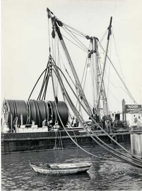
Verlegung von Rohren aus Hostalen GM 5010 aus der Produktion der Ruhrchemie AG (etwa 1970)
