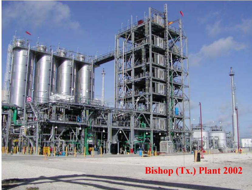
Neue GUR-Anlage der Ticona GmbH, einer Tochter der Celanese AG, in Bishop/Texas nach dem bewährtem Verfahren der Ruhrchemie AG
