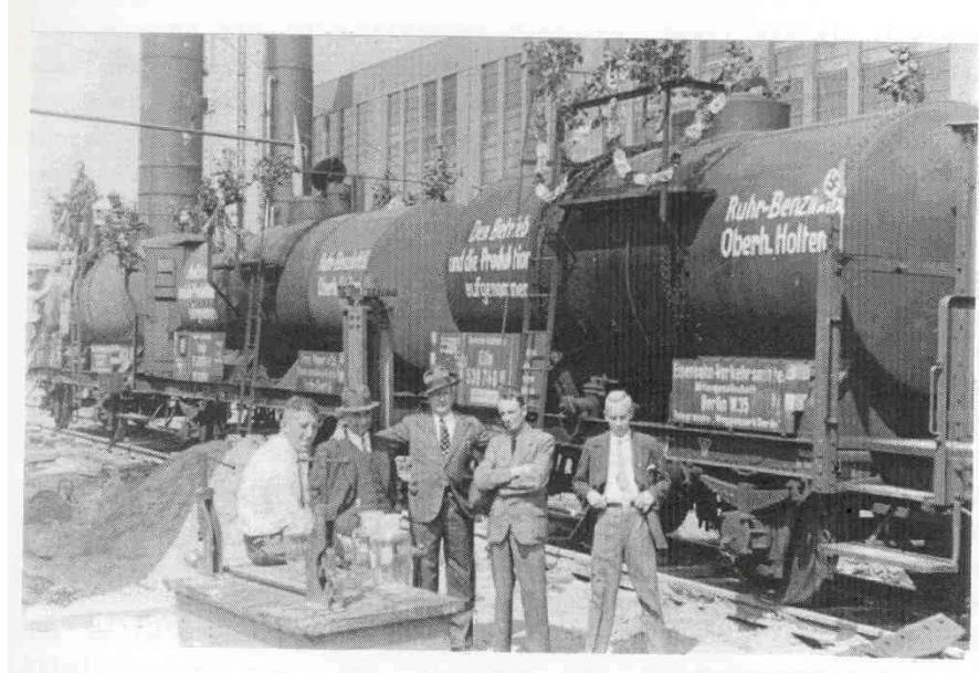
Das erste Benzin aus der neu errichteten Fischer-Tropsch-Anlage (1936)
