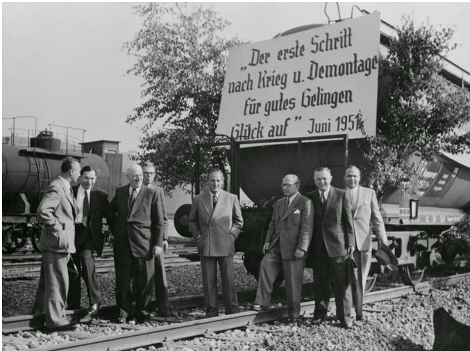
Anfahren der Erdölraffinerie der Ruhrchemie AG im Juni 1951. In der Mitte der damalige Vorstandsvorsitzende Dr. Tramm
