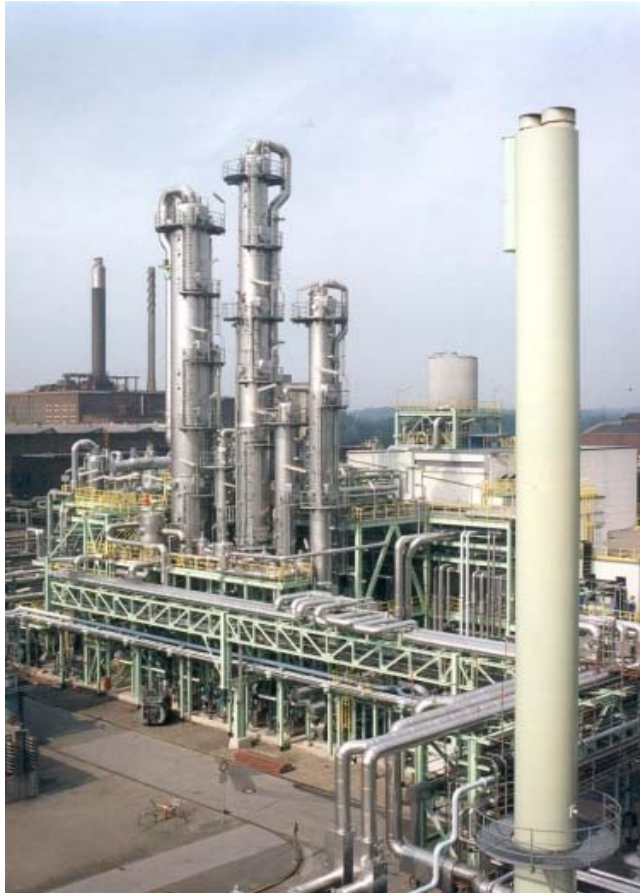
Produktionsanlage der Ticona GmbH zur Herstellung des COC-Copolymeren TOPAS® auf dem Gelände der ehemaligen Ruhrchemie AG in Oberhausen
